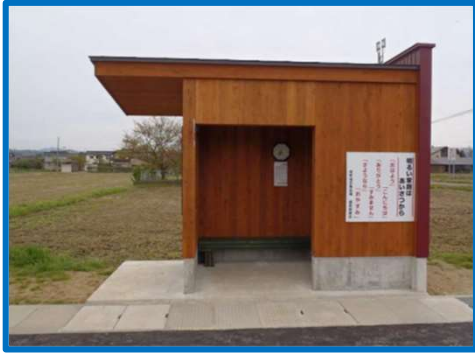
バス待合所／刈羽村 H28.3(構造材):12.3m 3 刈羽村 1階建て・壁、屋根
