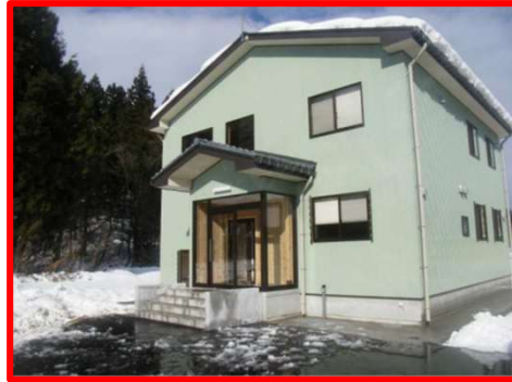
研究施設:中山間地農業技術センター／新潟県 H29.12(CLTパネル工法):54.6m 3 長岡市川口 2階建て・1棟
