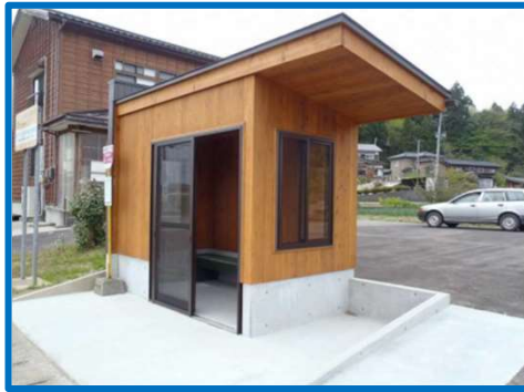
バス待合所／刈羽村 H28.3(構造材) 刈羽村 1階建て・壁、屋根
